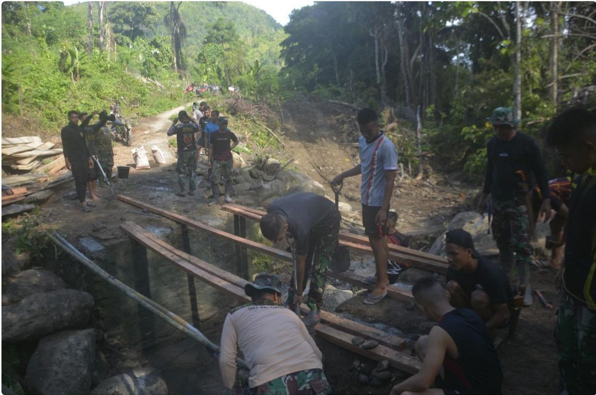
Proses rehabilitasi jembatan melibatkan anggota satgas TMMD dan warga setempat dan dimulai dengan pembongkaran jembatan lama yang sudah tidak layak pakai. Setelah itu, dilakukan penguatan pondasi dan pemasangan balok penyangga baru. Pekerjaan dilanjutkan dengan pemasangan lantai kayu yang lebih kokoh dan aman. Semua tahap rehabilitasi dilakukan dengan cermat untuk memastikan jembatan memiliki kualitas yang baik dan tahan lama.
